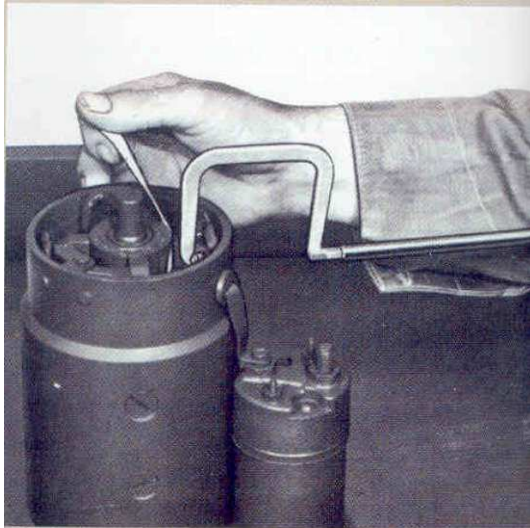
Prüfen der Bürstenfederkraft.
